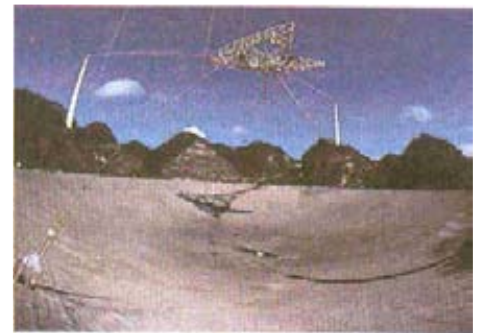
O observatório de rádio/radar de Arecibo, em Porto Rico. O disco refletor hemisférico está montado sob os braços do refletor, os quais são suportados por três grandes obeliscos, dois dos quais são vistos deformados na foto abaixo, tirada com uma lente olho de peixe ao nível dos painéis que formam o disco. Cortesia do National Astronomy and Ionosphere Center, Cornell University.
