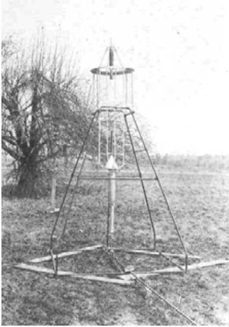
Primeiro foguete de produção líquida que nunca viajou. Lançado por Robert Goddard, a 16 de março de 1926, da fazenda de sua tia Effie, em Auburn, Massachusetts, seu vôo durou 2 1/2 segundos. Cortesia da Goddard Library, Clark University.
